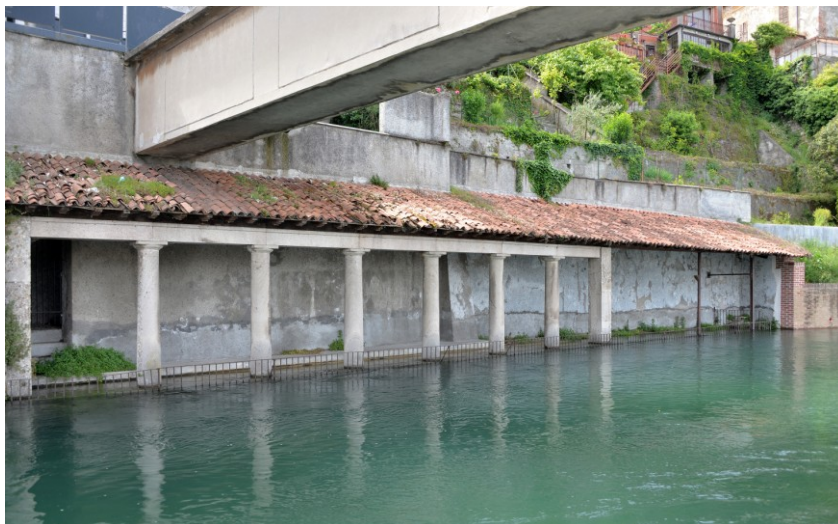
Foto 1 – Lo storico lavatoio, situazione attuale
